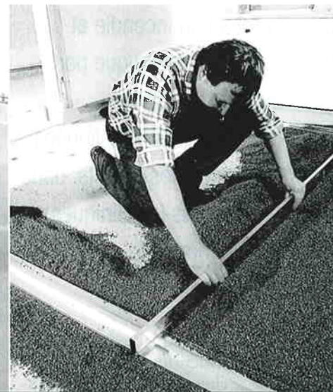
En haut, à gauche: plaque de chape en plâtre armé de fibres. En haut, à droite: plaque de chape composite avec laine minérale. En bas, à gauche: pose d'une feuille protectrice contre la dispersion des débris pulvérulents. En bas, à droite: pose et nivelage au platoir de la couche de nivellement (granulé).
