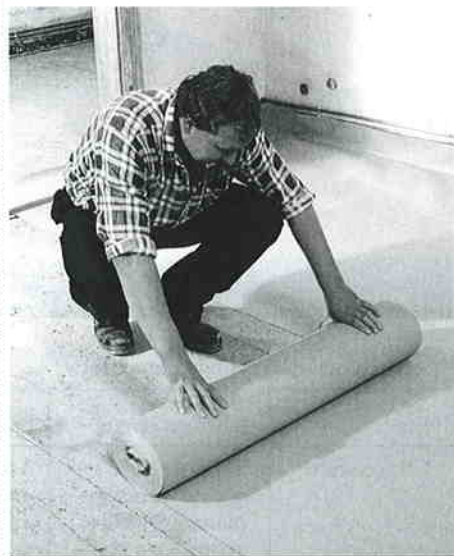
En haut, à gauche: plaque de chape en plâtre armé de fibres. En haut, à droite: plaque de chape composite avec laine minérale. En bas, à gauche: pose d'une feuille protectrice contre la dispersion des débris pulvérulents. En bas, à droite: pose et nivelage au platoir de la couche de nivellement (granulé).
