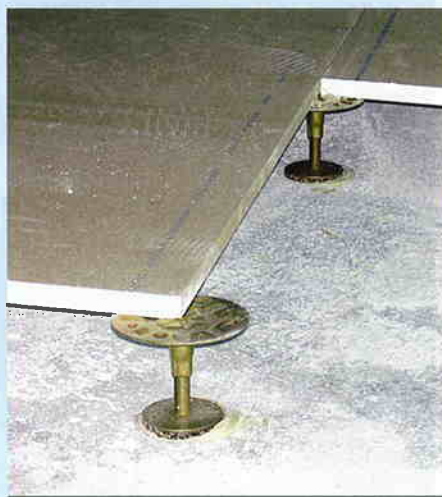
Pose des plaques sur le support. Montage d'un cadre de trappe d'accès.
