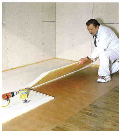
Pose d'une chape sèche (assainissement). Coulloir technique aménagé sous le faux plancher.
