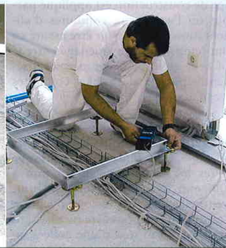
Pose des plaques sur le support. Montage d'un cadre de trappe d'accès.
