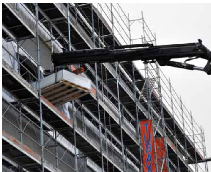
Livraison des plaques de plâtre pour les plafonds
