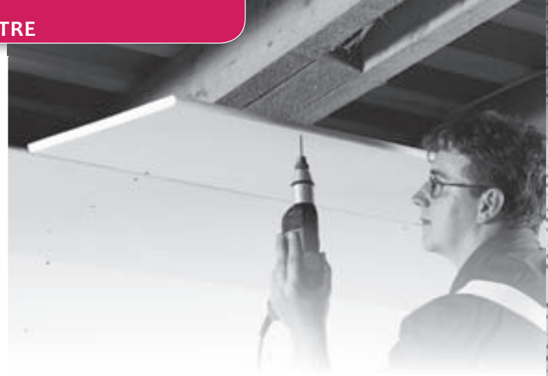
Revêtement. Montage direct sous solivage bois. PHOTO SVGG
