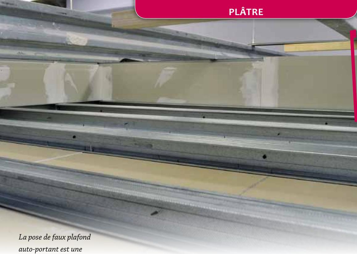
*La pose de faux plafond auto-portant est une technique permettant de ne mettre aucune suspension.*
