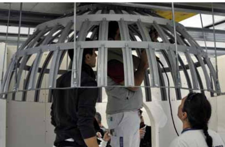
Fixation au plafond de la coupole avec suspension Nonius
