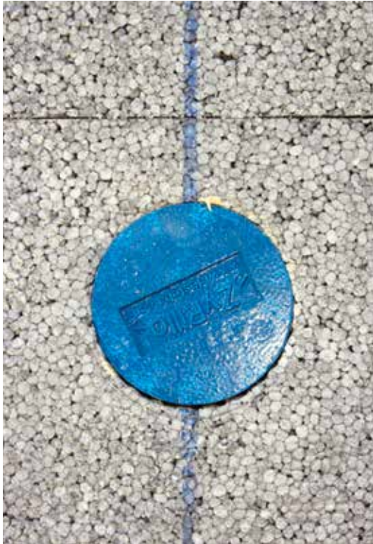
L'élément de montage Zyrillo est inséré dans l'épaisseur de l'isolant, il permet de reprendre les charges légères d'un collier de descente d'eau pluviale.
