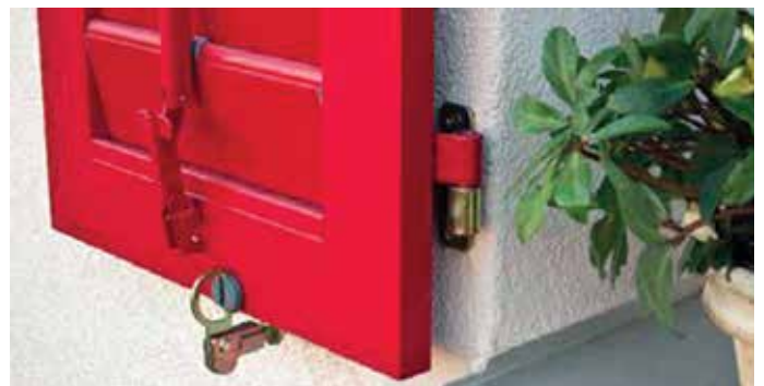
Lorsque le volet est posé, l'élément de renfort n'est plus visible et reçoit une finition identique à la façade crépie.
