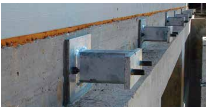
Ce détail n'est pas correct. Le métal est un excellent conducteur thermique. Le risque de se retrouver avec des tâches à l'intérieur de l'habitation est programmé.
