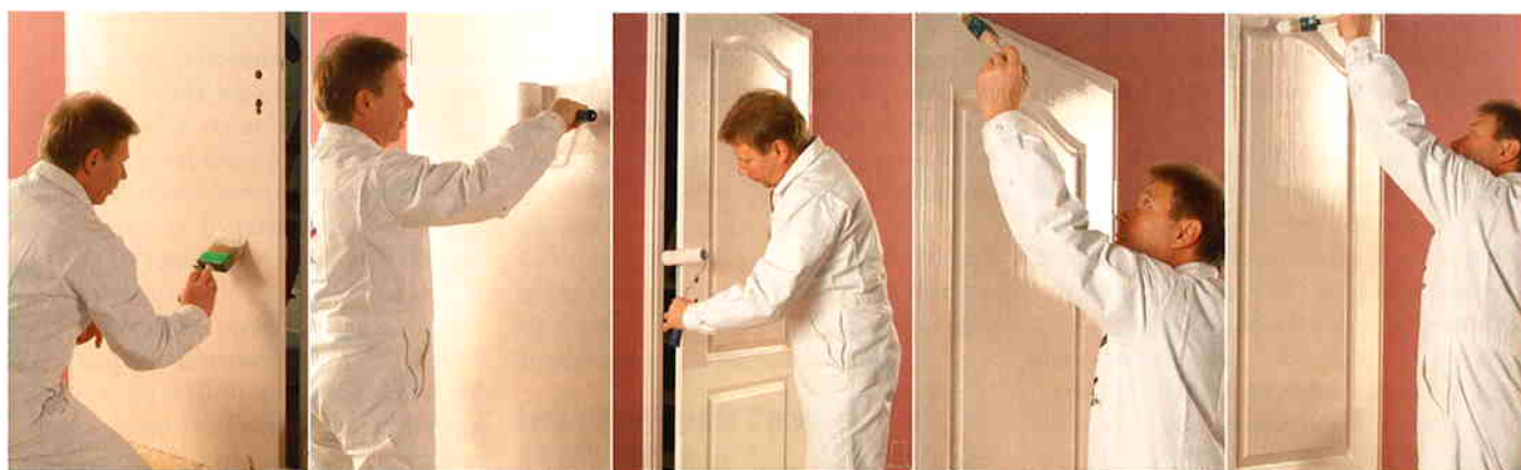
A gauche: application et finition au pinceau. A droite: application et finition au rouleau.
