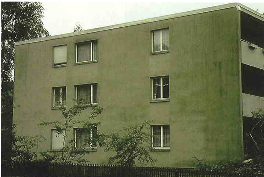
L'application de la nouvelle ordonnance sur les produits biocides a des répercussions importantes sur la fabrication et l'utilisation des produits contre les algues (photo) et les champignons.
