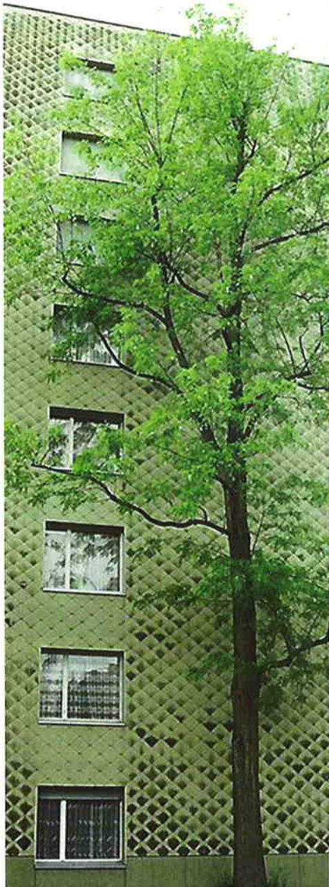
Les objets dégradés par des microorganismes sont nombreux. A gauche, une façade en Eternit «colonisée» par des champignons; en haut, une attaque dans un local d'intérieur, particulièrement exposé si le taux d'humidité est élevé. En bas, quelques exemples de la vaste gamme de produits de traitement.
