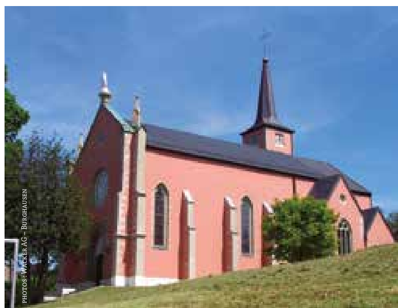
Eglise de Bernex: peinture pour façades à base de silicone
