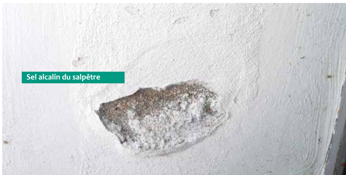
Bas de murs en mortier traditionnel, ayant une moindre possibilité d'absorption d'humidité qu'un mortier à base de Trass. Cette réparation avait été réalisée il y a environ 18 mois.
