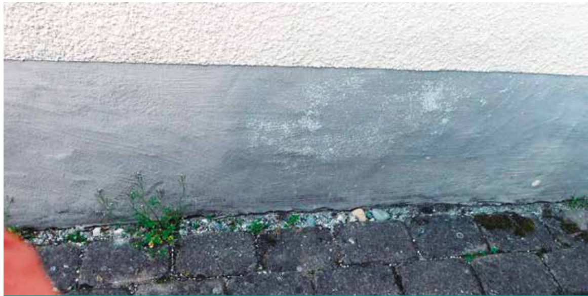
Soubassement en mortier à base de Trass et peinture organique renforcée au siloxane
