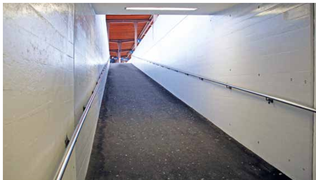
Les résines ou peintures époxy sont également souvent appliquées sur les murs à forte sollicitation.
