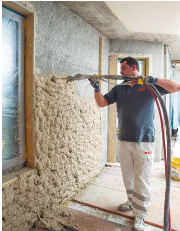
Applicable aisément, l'Aérogel enduit thermo-isolant haute performance permet de réaliser des couches de jusqu'à 80 mm d'épaisseur en une opération (© Daniel Reinhard, Sachseln).
