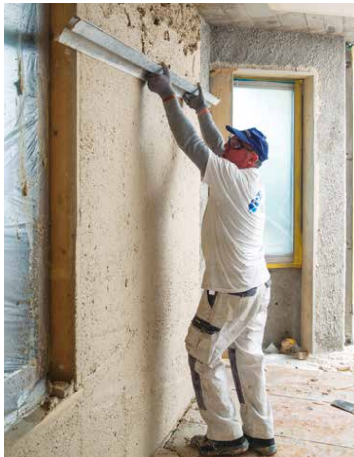
Applicable aisément, l'Aérogel enduit thermo-isolant haute performance permet de réaliser des couches de jusqu'à 80 mm d'épaisseur en une opération (© Daniel Reinhard, Sachseln).
