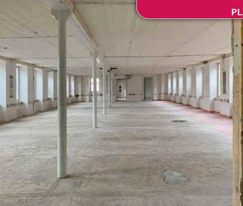
térieures sont composées de poutres recouvertes de planchers et soutenues au centre par des piliers métalliques. Les anciens plafonds sont en lattis enduits. La résistance qui nous a été demandée est EI60 entre les étages et entre les appartements.
