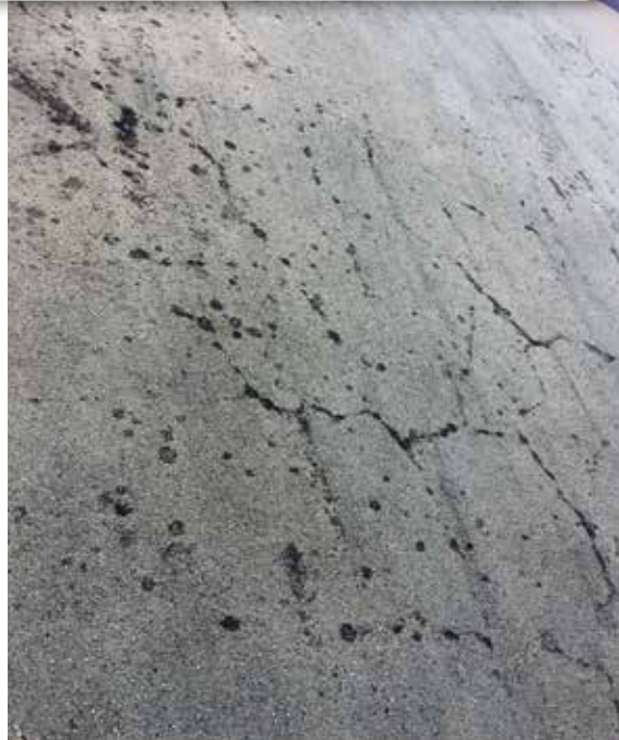
Mousse et micro-fissures = dégradation des supports
