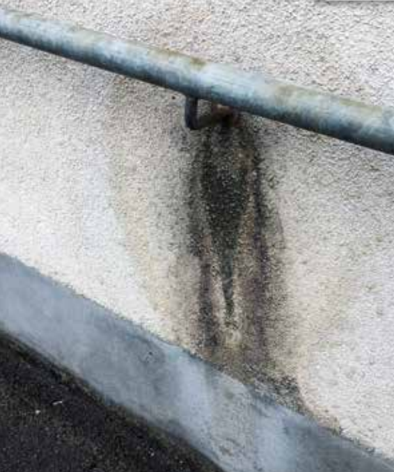
Détail de construction entraînant des dégâts
