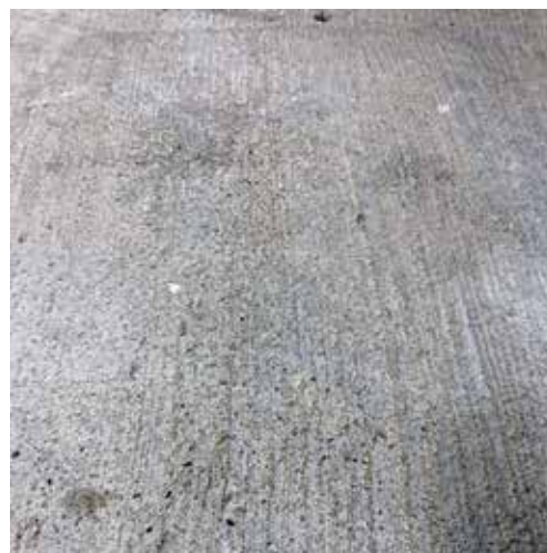
Grenaillage à sec avec billes d'acier.
