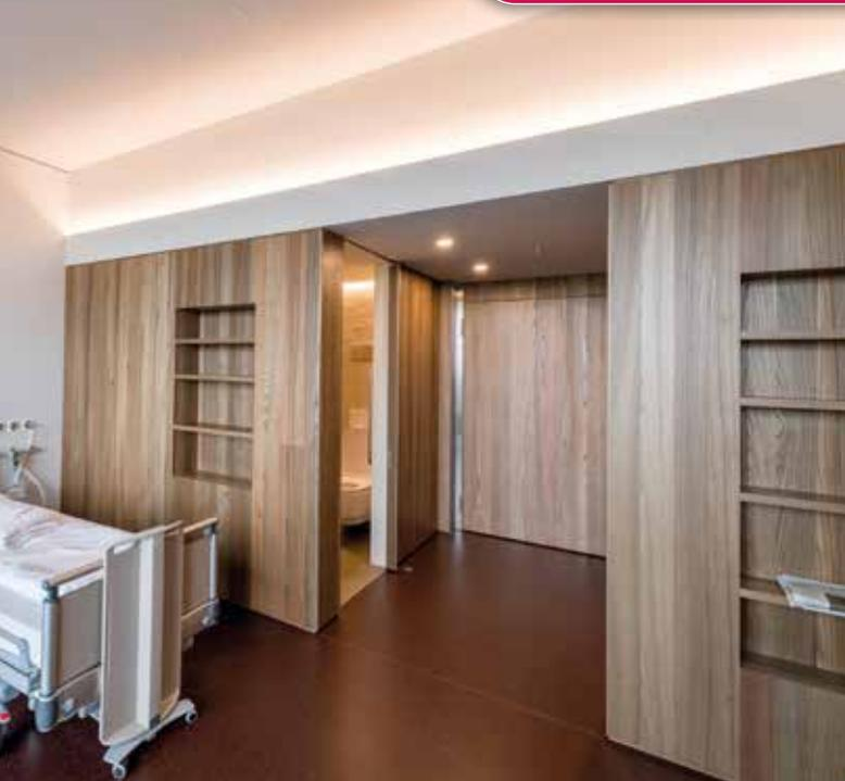
Le panneau incliné pour l'éclairage indirect est également réalisé au moyen de systèmes de construction à sec en plâtre.
