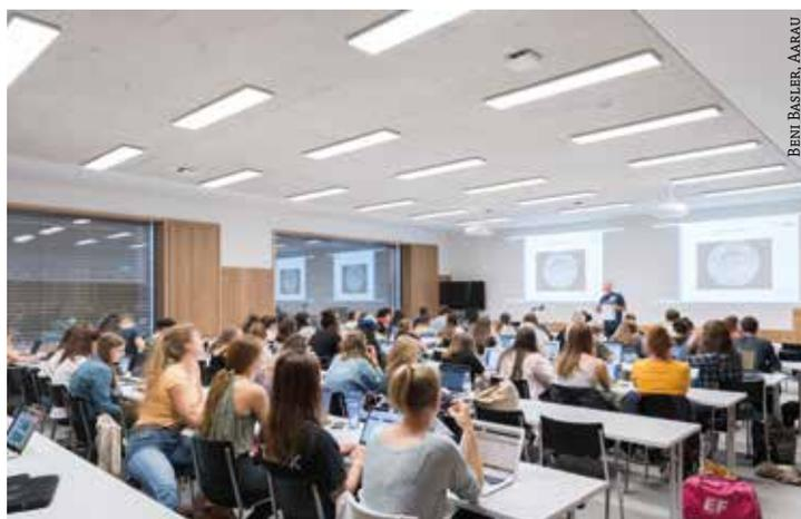
*Dans les auditories, une grille de profilés à grande portée sert de zone de montage renforcée de carreaux de plâtre de 40 mm comme surface de réflexion dans la partie supérieure des murs, tandis qu'un lattage en bois absorbe le bruit dans la partie inférieure.*
