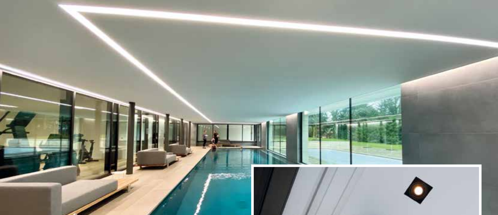
La toile tendue de 180 m 2 a été posée par R. Mazzoli SA.
