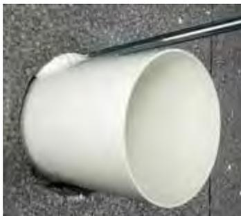
*Avec le pistolet à projeter, injecter la mousse sans excès dans le joint pour former un cordon continu.*
