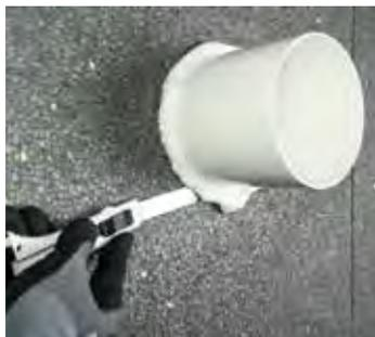
*Retirer les parties de mousse saillante à l'aide d'un cutter tranchant après durcissement complet.*
