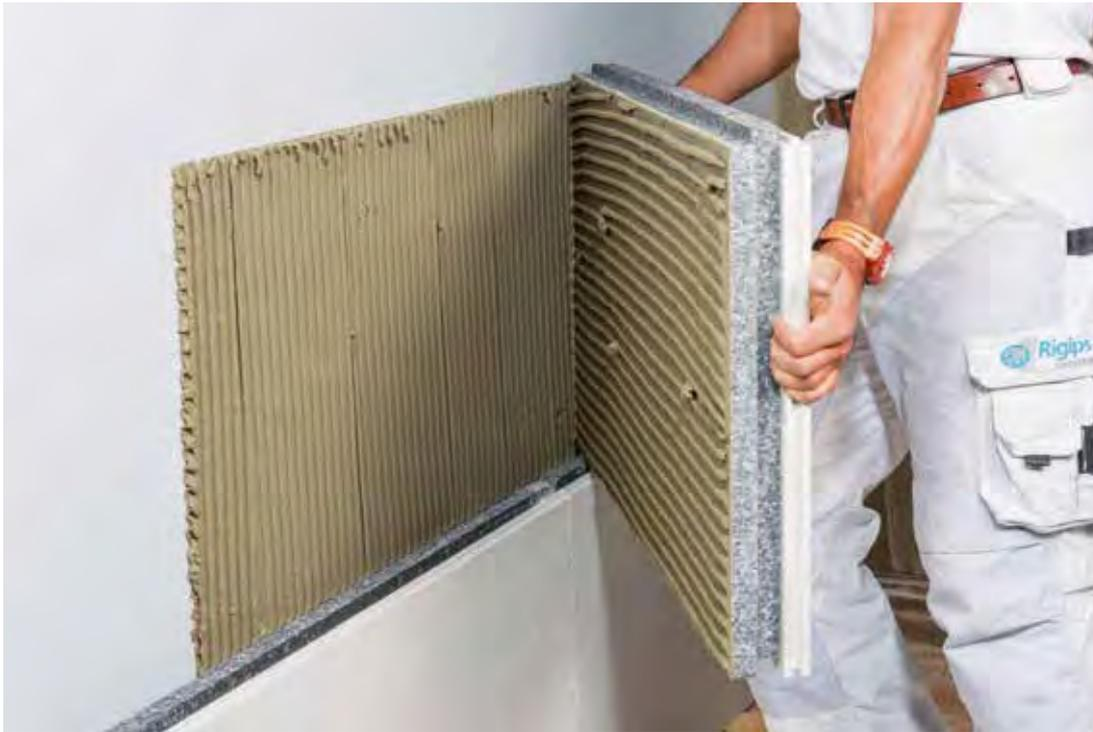
*Il faut utiliser différents types de colles en fonction du support pour fixer les panneaux composites en toute sécurité. Il est crucial d'utiliser la colle de système originale.*
