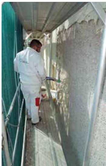
*L'enduit isolant haute performance aérogel peut être appliqué en une seule opération en épaisseurs allant jusqu'à 80 mm.*
