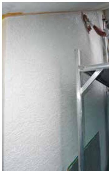
*Application du crépi de finition Fixit 777 avec une structure rainurée grossière.*
