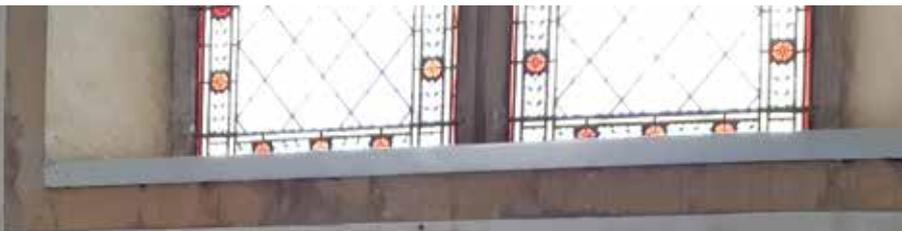
*Exemple de salissures vers de petites fissures, dues à la fixation de la poussière par l'humidité de condensation due à une peinture trop peu absorbante.*
