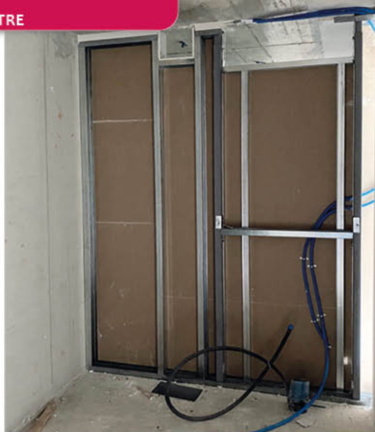
Complément d'aménagement ajouté à une cloison légère d'appartement avec sous-construction appropriée pour permettre l'absorption de la charge imposée par les installations sanitaires.
