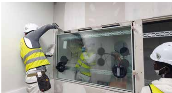
Remplissage des vitrages au mortier colle RF1 pour le scellement.
