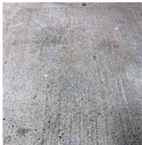
Grenaillage à sec avec billes d'acier.
