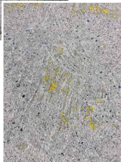
Meulage ou fraisage au disque diamant.
