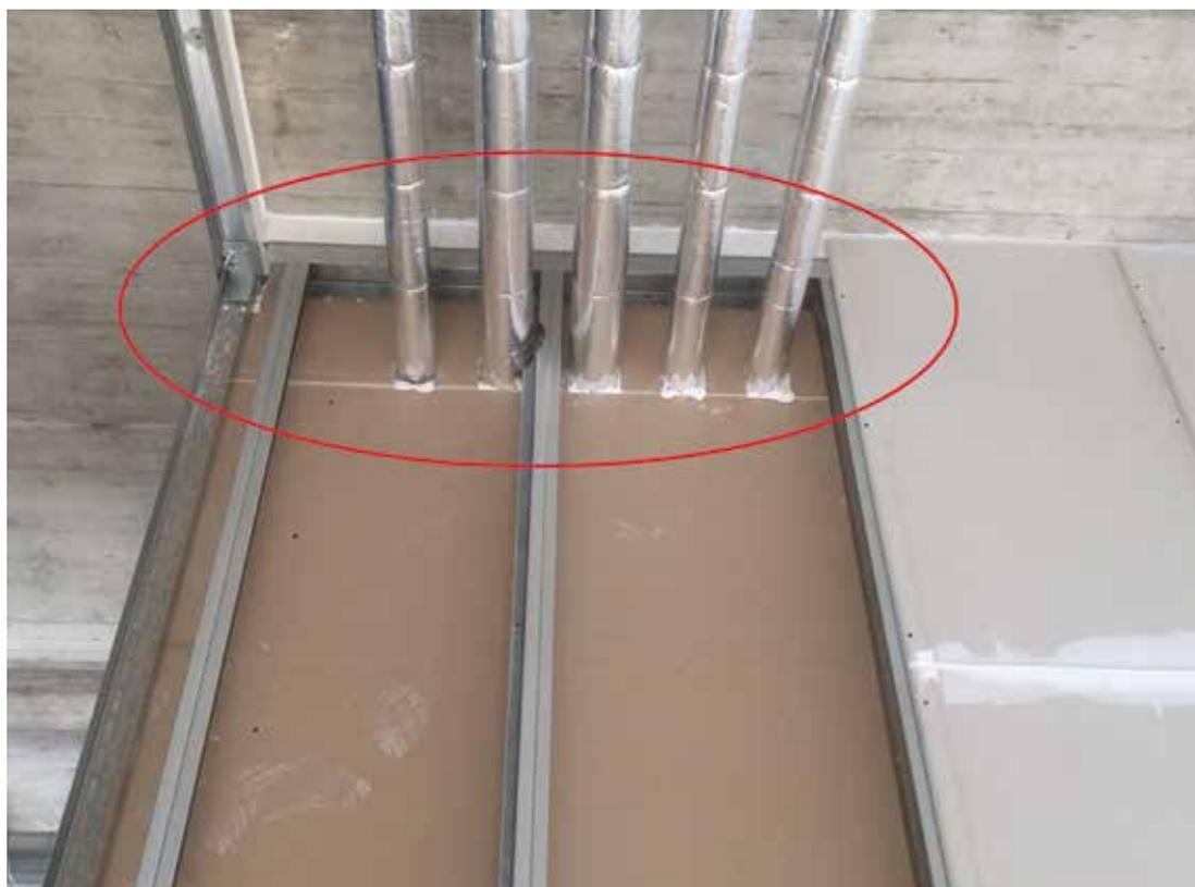
*Raccord étanche au plafond du bloc de plâtre et étanchéité propre autour des passages de conduites.*
