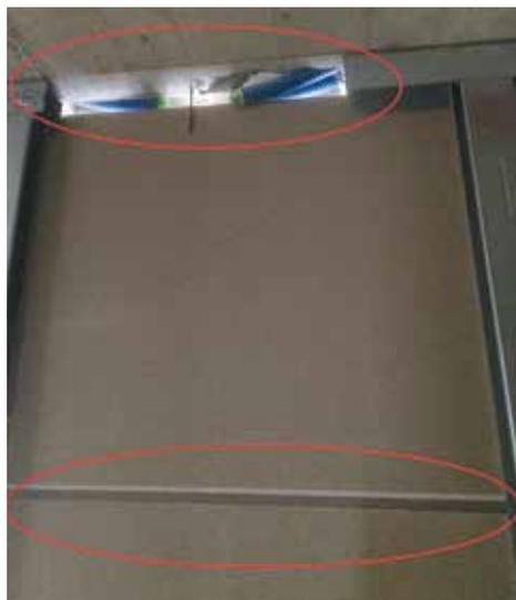
*Les dégâts sont programmés d'avance : Le profilé de raccordement au plafond est découpé, les tuyaux électriques sortent du plafond au mauvais endroit. La première couche de plaques n'a pas été enduite.*
