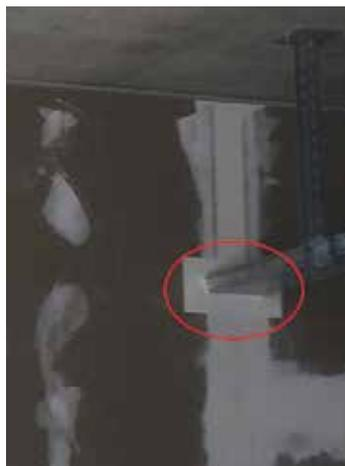
*Chemin de câbles passant à travers le profilé mural, dépenses supplémentaires dues à l'installation ultérieure d'un échangeur.*
