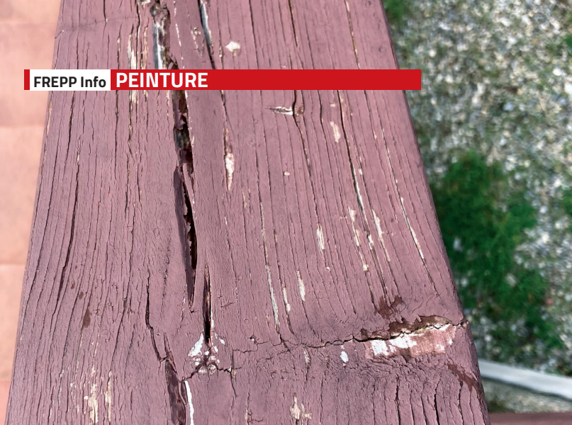
Un bois de mauvaise qualité, une préparation inadaptée et l'humidité entraînent de la fissuration importante.
