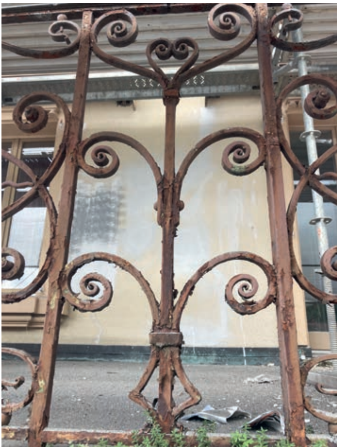
Le sablage ou le micro-gommage sont les meilleurs moyens de nettoyage du métal (balustrade avant et après).
