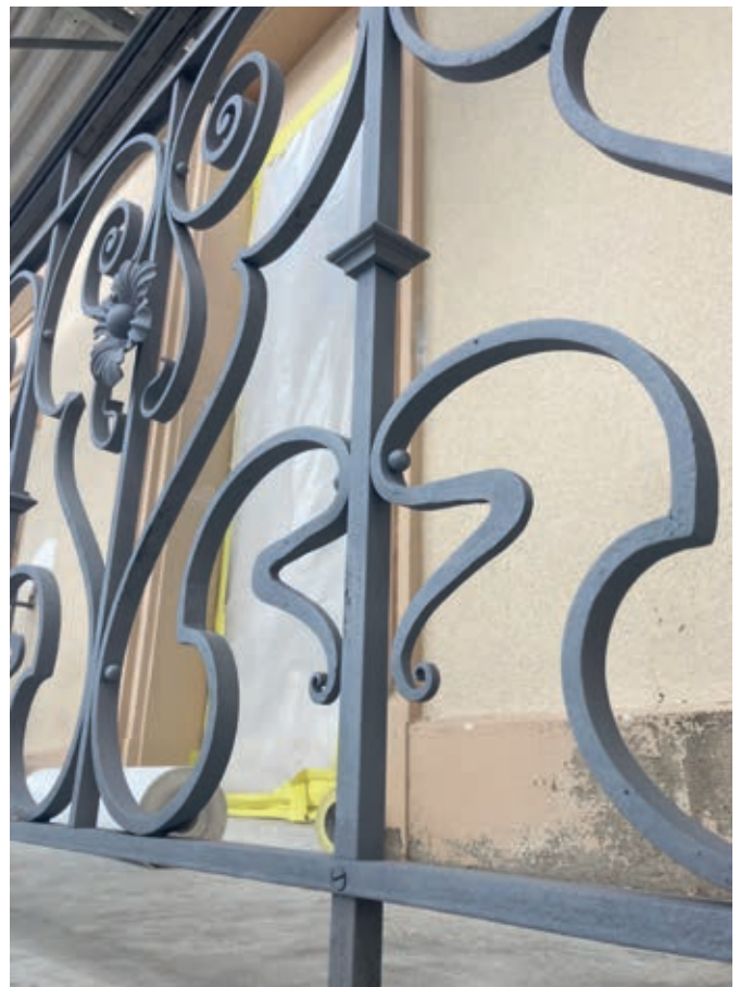
Le sablage ou le micro-gommage sont les meilleurs moyens de nettoyage du métal (balustrade avant et après).
