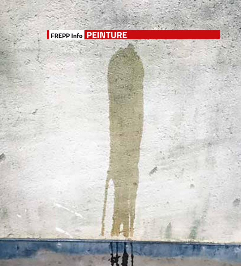
Test à l'eau : un moyen tout simple pour déterminer la nature du support.
