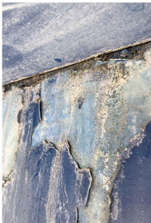
Meulage ou sablage sur métal ?
