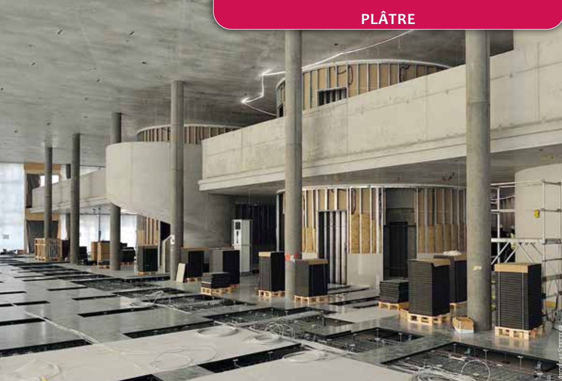
Toutes les subdivisions spatiales sont réalisées avec des systèmes de construction à sec.
