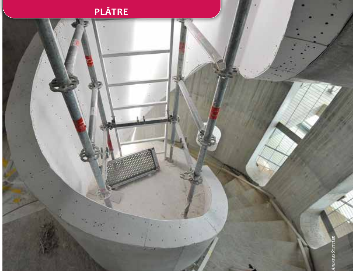
Les rayons étroits des volées d'escalier ont pu être réalisés avec des plaques normales, mais rainurées, de 12,5 mm et des plaques GK de 6 mm.
