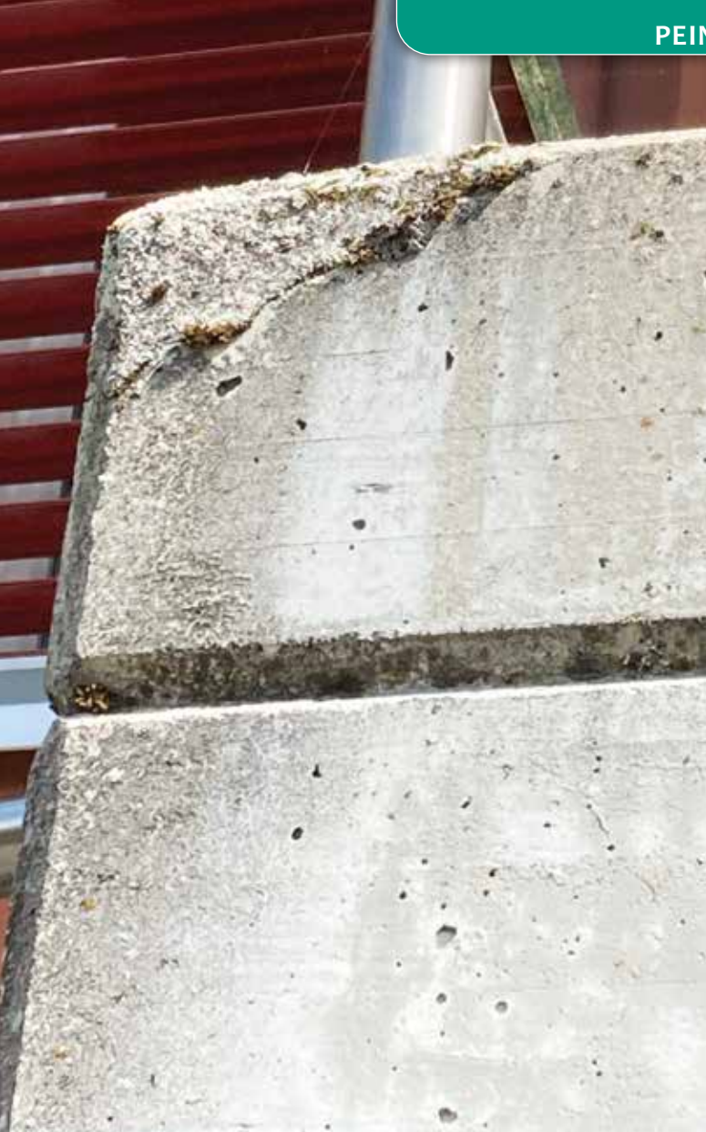
Des surfaces en béton présentant à la fois des efflorescences, des fissures, des poches, de la moisissure
