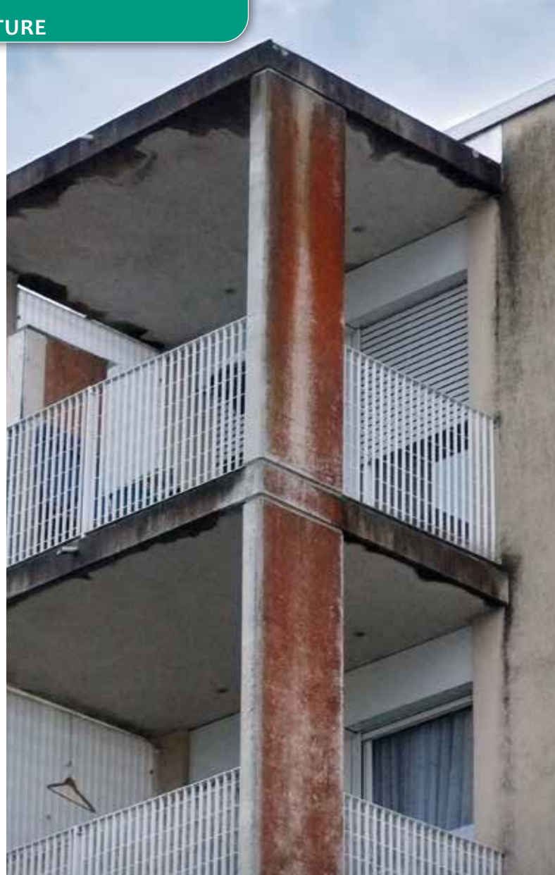
Des surfaces en béton présentant à la fois des efflorescences, des fissures, des poches, de la moisissure
